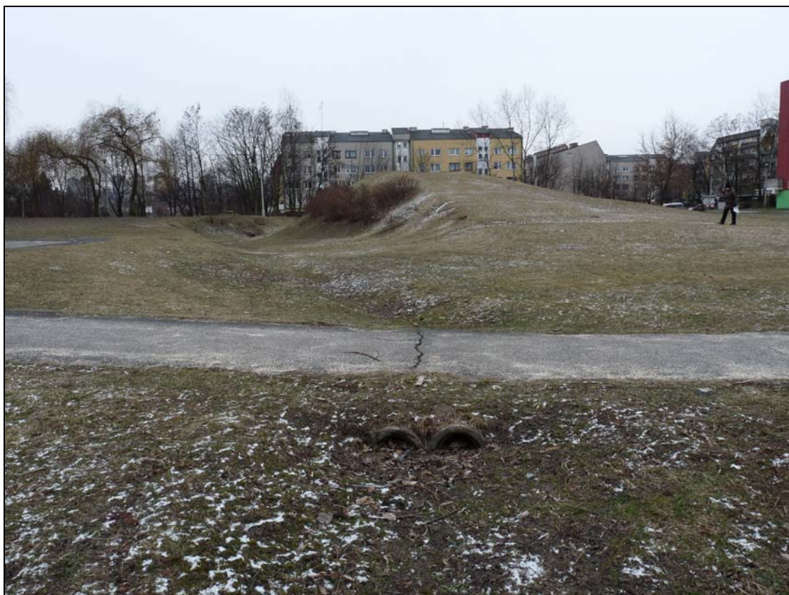
Fot.5 Elementy nieczynnego przepustu - pozostałości po dawnym rowie przebiegającym przez teren opracowania. Obiekt do likwidacji przy wymianie nawierzchni chodnika.
